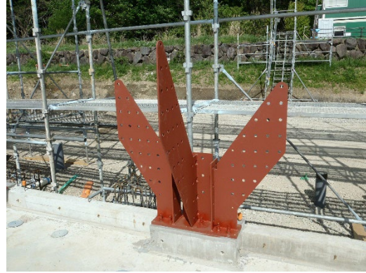
図 4.15 柱脚金物 (左：柱脚金物、右：筋かい付き柱脚金物)
