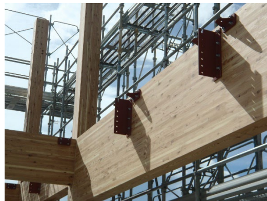
図 4.16 梁受け金物 (左：大梁受け、右：小梁受け)
