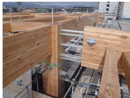
図 23.16 GIR 接合断面図
