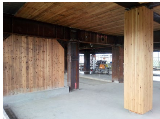
写真 8.4 PARK WOOD 高森 工事中の風景
