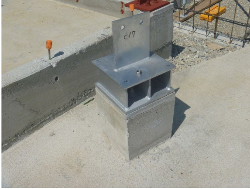
図 4.15 柱脚金物 (左：柱脚金物、右：筋かい付き柱脚金物)
