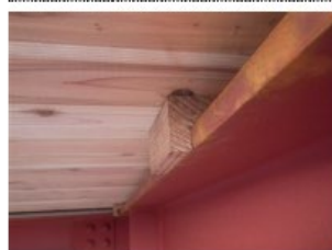
【CLTと梁のクリアランス確保】
