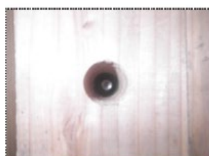
【切断後のスタッドとCLT孔位置】
