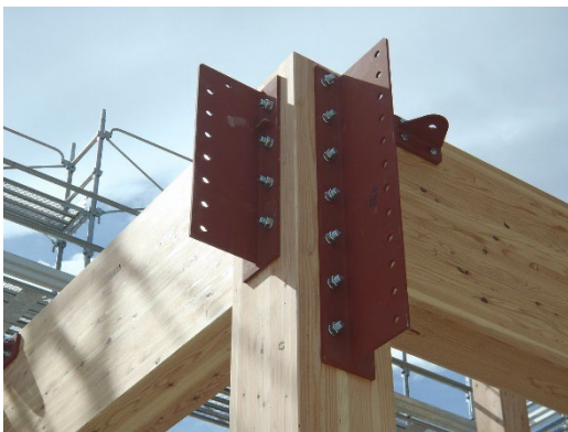
図 4.16 梁受け金物 (左：大梁受け、右：小梁受け)
