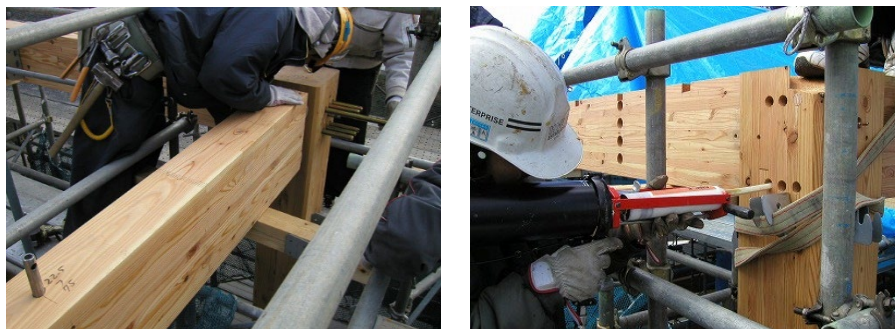
図 4.13 GIR による柱-梁接合部の例
