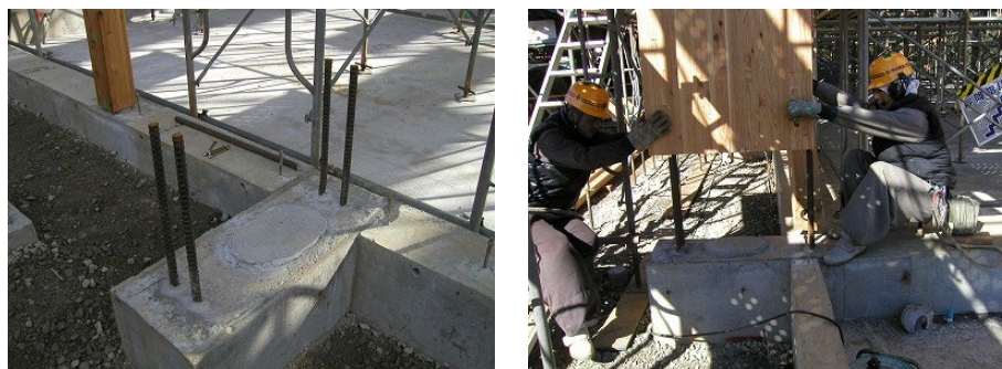
図 4.14 GIR による柱脚接合部の例
