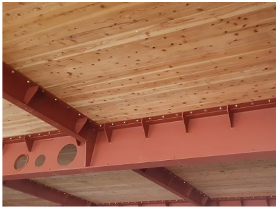
写真 8.5 鉄骨梁と CLT 床の LSB 接合
