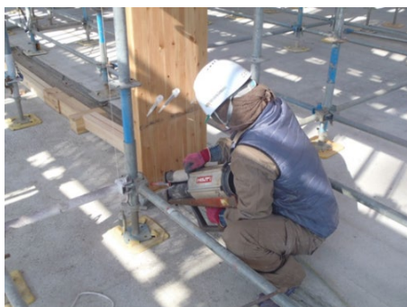
図 23.15 GIR 接合（樹脂注入状況）
