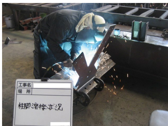
図 18.8 柱脚金物の溶接
