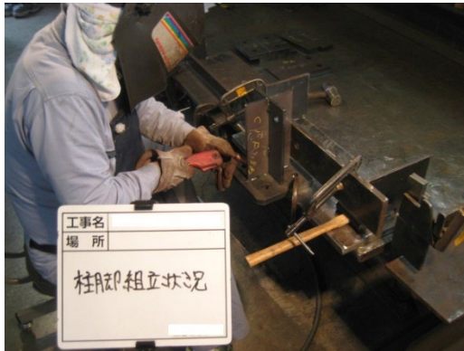
図 18.6 柱脚金物の組立て
