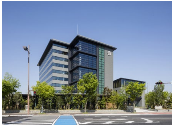
写真1) 松尾建設本店ビル外観
