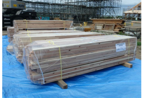
図 22.6 木質構造部材の荷置き状態
