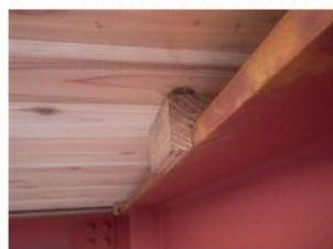
【CLTと梁のクリアランス確保】
