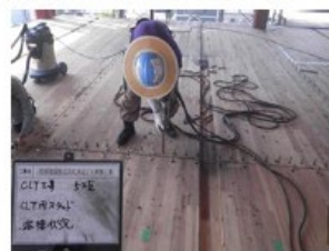
【スタッド溶接】
