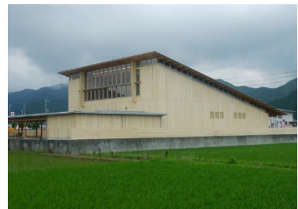
図 6.13 外壁にアセチル化処理した木材の使用例
