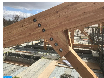
図 23.10 ボルト接合拡大
