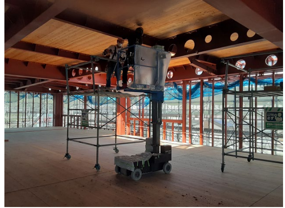
写真 8.6 高所作業車による作業風景
