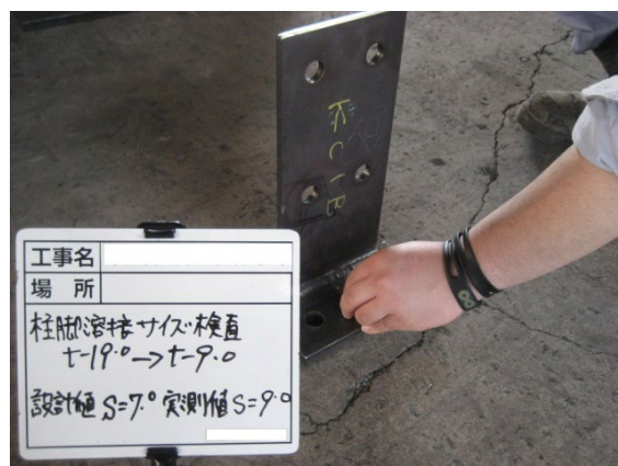
図 18.9 溶接サイズ検査
