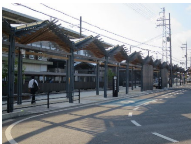
図 6.11 熱処理した木材の使用例
