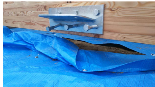
図 23.12 ラグスクリュー接合拡大
