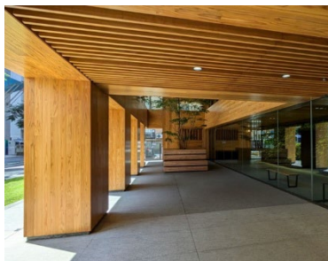
図 6.12 軒に樹脂処理した木材の使用例
