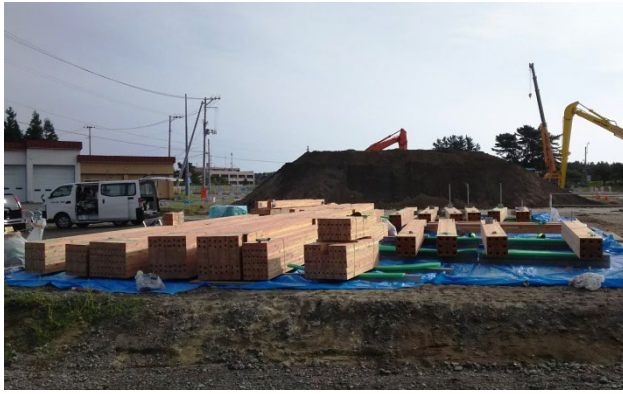
図 22.6 木質構造部材の荷置き状態
