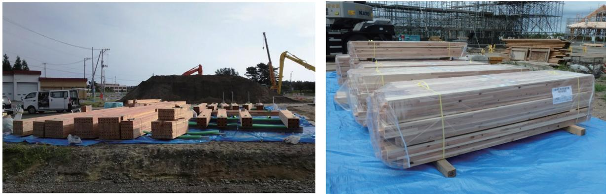
図 3.6 木質構造部材の荷置き状態
