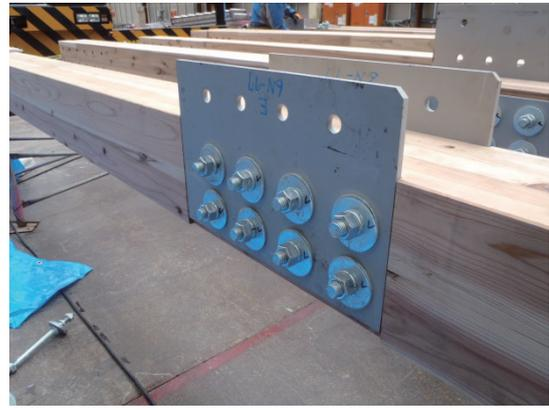
図 3.16 ボルト接合拡大
