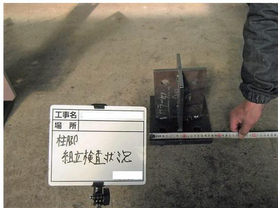
図 5.7 組立ての精度検査
