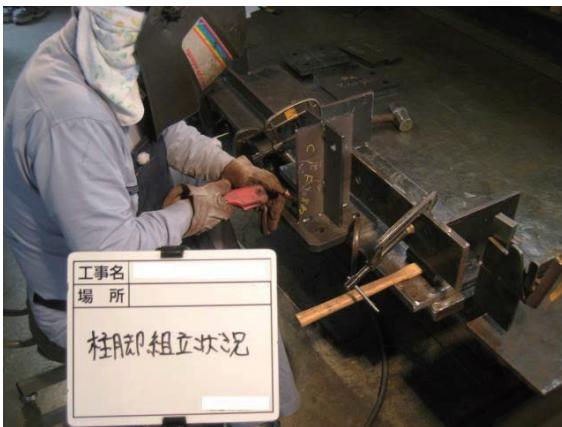
図 5.6 柱脚金物の組立て
