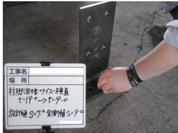
図 5.9 溶接サイズ検査
