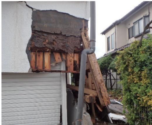
図 6.4 腐朽と蟻害で耐震性を失った事例
