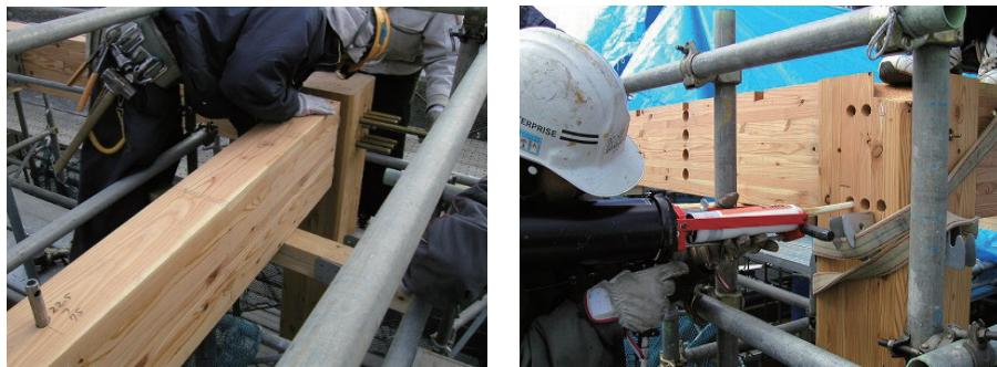
図 4.13 GIR による柱-梁接合部の例
