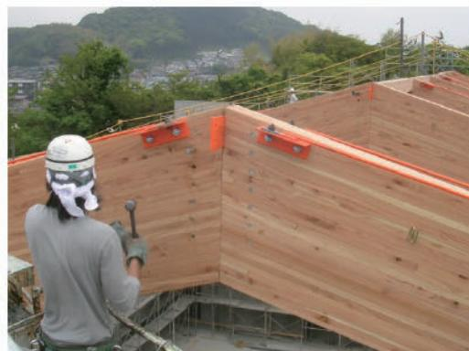
図 3.20 ドリフトピン接合拡大
