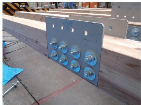
図 3.16 ボルト接合拡大
