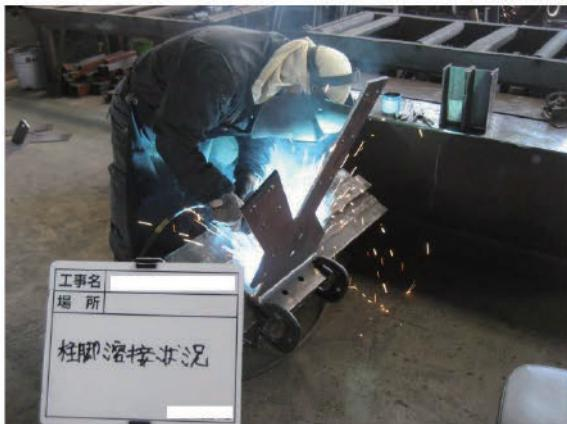
図 5.8 柱脚金物の溶接
