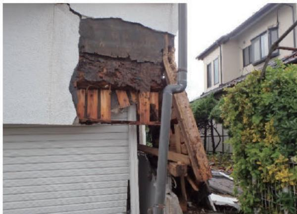
図 6.4 腐朽と蟻害で耐震性を失った事例
