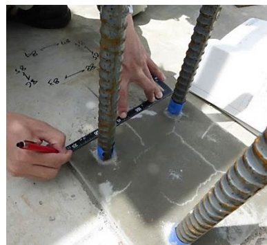
図 22.2 アンカーボルト位置確認
