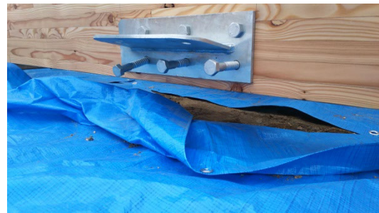
図 23.12 ラグスクリュー接合拡大
