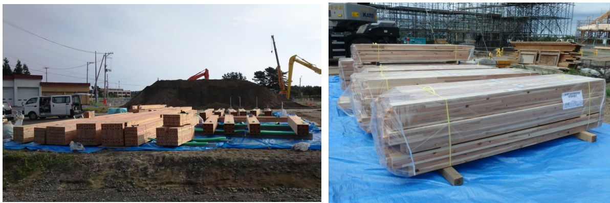
図 22.6 木質構造部材の荷置き状態
