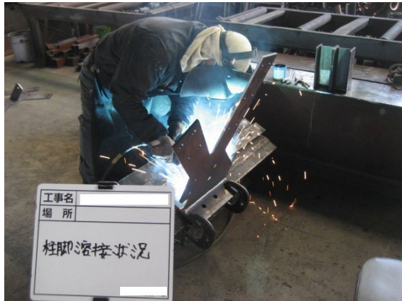
図 18.8 柱脚金物の溶接
