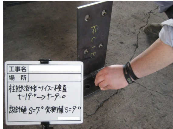
図 18.9 溶接サイズ検査
