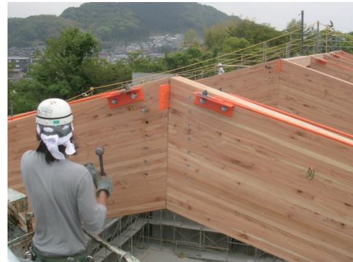
図 3.20 ドリフトピン接合拡大
