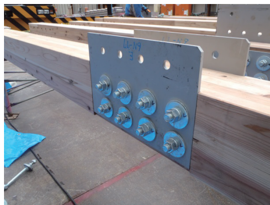
図 3.16 ボルト接合拡大
