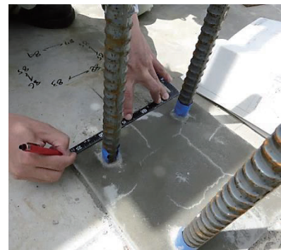
図 3.2 アンカーボルト位置確認
