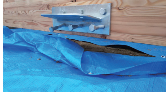
図 3.18 ラグスクリュー接合拡大
