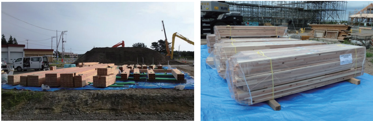
図 3.6 木質構造部材の荷置き状態
