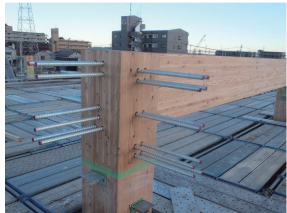
図 3.22 GIR 接合断面
