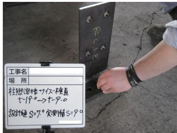
図 5.9 溶接サイズ検査
