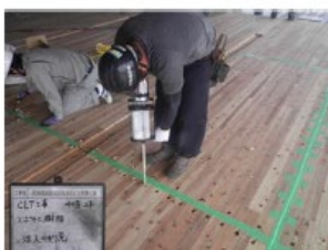
【エポキシ樹脂注入】
