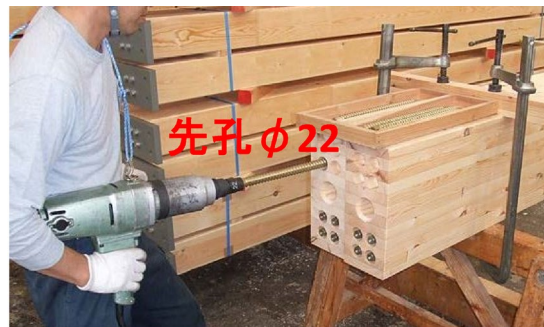
図 4.11 LSB 打ち込み状況
