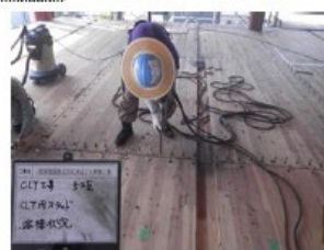
【スタッド溶接】
