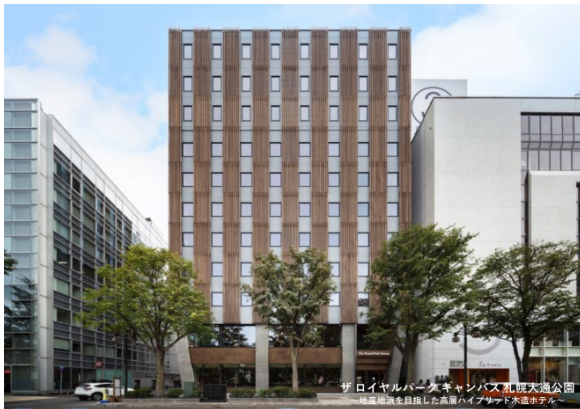
写真 8.7 建物立面全景
