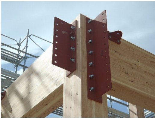
図 4.16 梁受け金物 (左：大梁受け、右：小梁受け)
