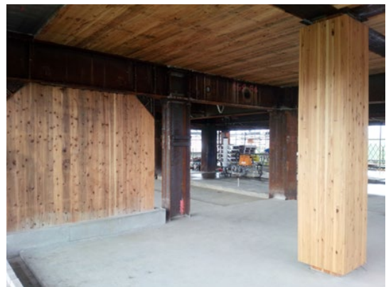
写真 8.4 PARK WOOD 高森 工事中の風景
