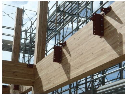
図 4.16 梁受け金物 (左：大梁受け、右：小梁受け)
