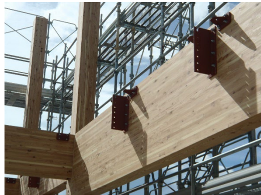
図 4.16 梁受け金物 (左：大梁受け、右：小梁受け)
