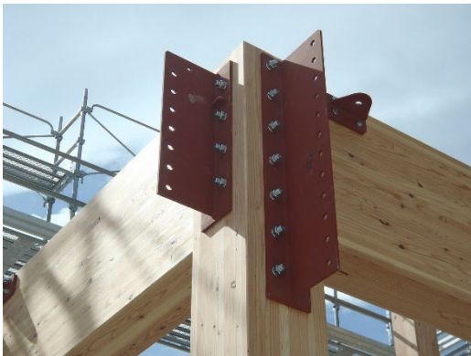
図 4.16 梁受け金物 (左：大梁受け、右：小梁受け)
