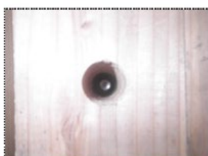
【切断後のスタッドとCLT孔位置】
