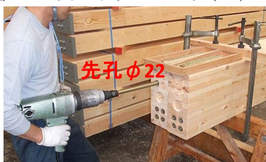
図 4.11 LSB 打ち込み状況
