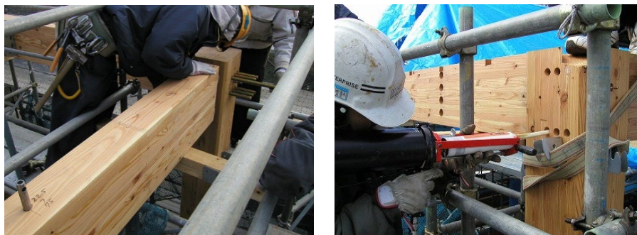
図 4.13 GIR による柱-梁接合部の例
