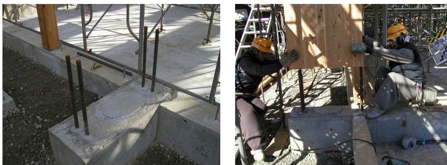
図 4.14 GIR による柱脚接合部の例
