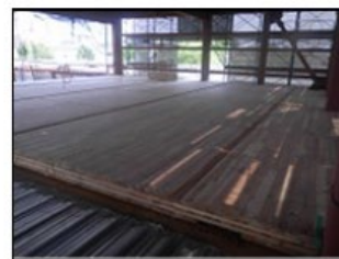
【CLT吊込完了】
